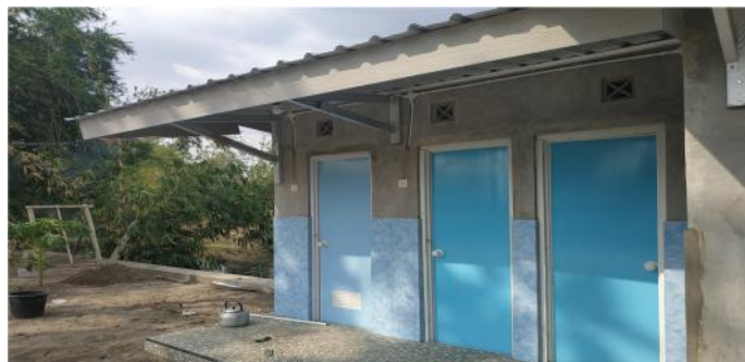
Gambar 5. Hasil Pembangunan toilet, sumur dan gudang
