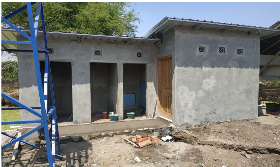
Gambar 4. Hasil Pembangunan Toilet dan Gudang
